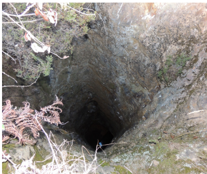
POZO VERTICAL. VISTA DESDE EL EXTERIOR Y DESDE LA GALERÍA
